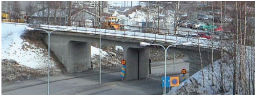
Obr. 1 – Železniční most Ömsköldsvik ve Švédsku před zatěžovací zkouškou
