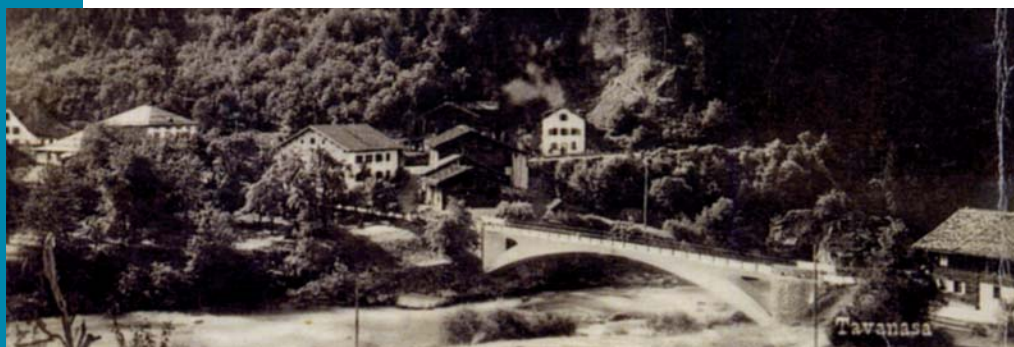
Na dobové pohlednici je železobetonový obloukový most Tavanasa od Roberta Malliarta z roku 1905, který stával v horské vesničce Grisons na horním toku Rýna ve Švýcarsku. V 2. polovině 20. století ho strhla velká povodeň a byl nahrazen novým vysokým obloukovým železobetonovým mostem.
